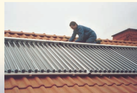
Montage einer thermischen Solaranlage
