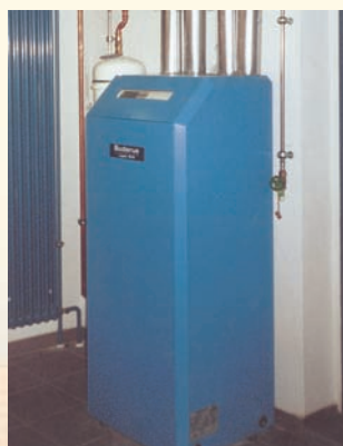
Wasser/Wasser-Wärmepumpe Berufsschule Chemnitz
